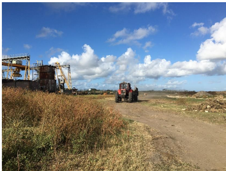
Figure 44: Chemin traversant le site de projet, vue vers l'Ouest
